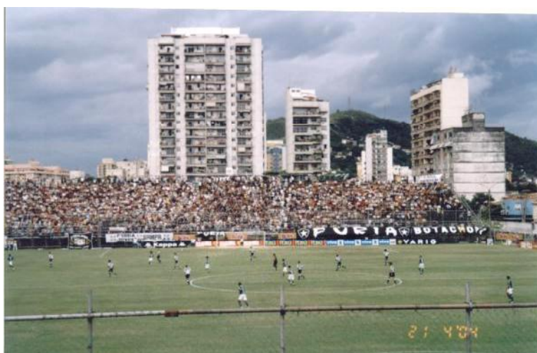
Figura 40: Caio Martins, arquibancadas tubulares. Em estrutura desmontável, foi erguida em 2003 em caráter provisório. Nelas se acomodam as torcidas organizadas do clube
