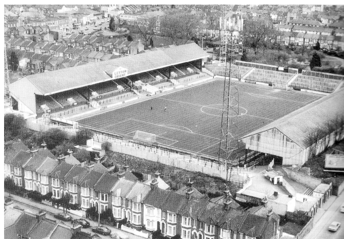
Figura 3: Brisbane Road, estádio do clube Leyton Orient, construído seguindo o modelo clássico inglês: arquibancadas cobertas nas laterais e os terraces atrás dos gols. Inglis, Simon. Football grounds of Britain , 1996
