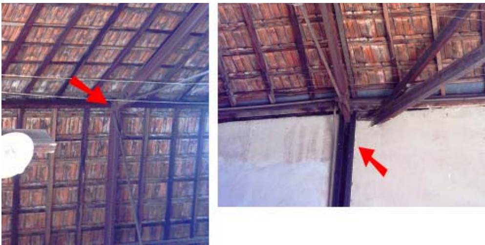
Figura 10: Fotos atuais da sustentação do telhado de um antigo barracão do Grêmio R.E.C.P.E.F..
