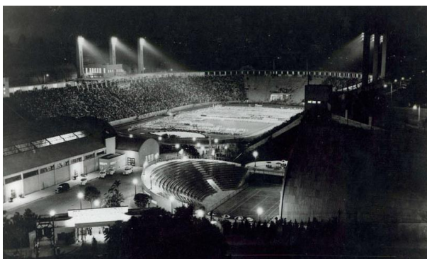
Figura 27- Vista do Complexo do Pacaembu. Fonte: Acervo da Biblioteca da FAU/USP.
