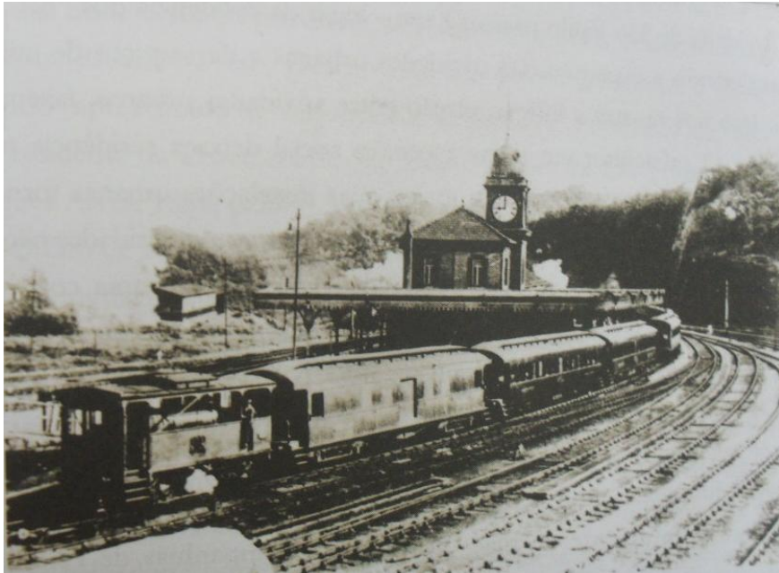
Foto 18: Pátio Ferroviário de Paranapiacaba – década de 20.
