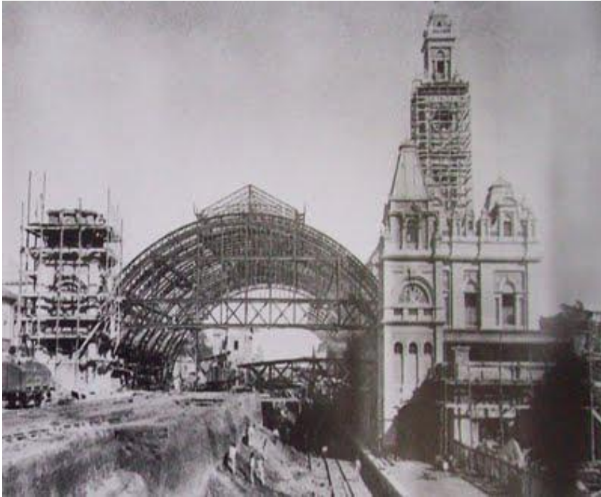
Foto 17: Estação Luz, em construção (1898).
