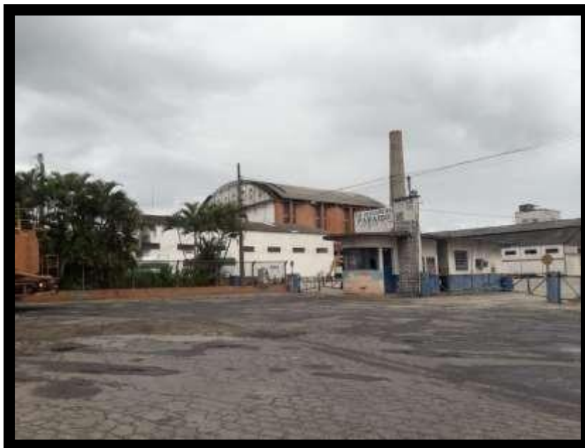
Figura 3 - Entrada da Usina Paraíso.
