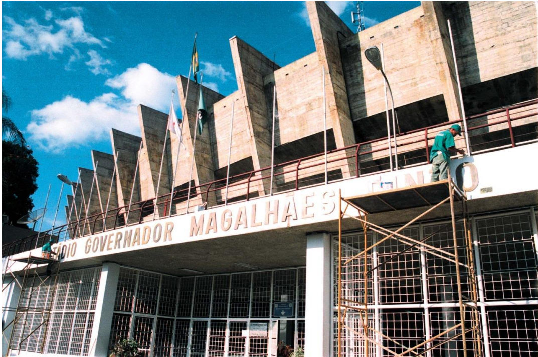
Figura 14 – Fachada/Entrada do Mineirão
