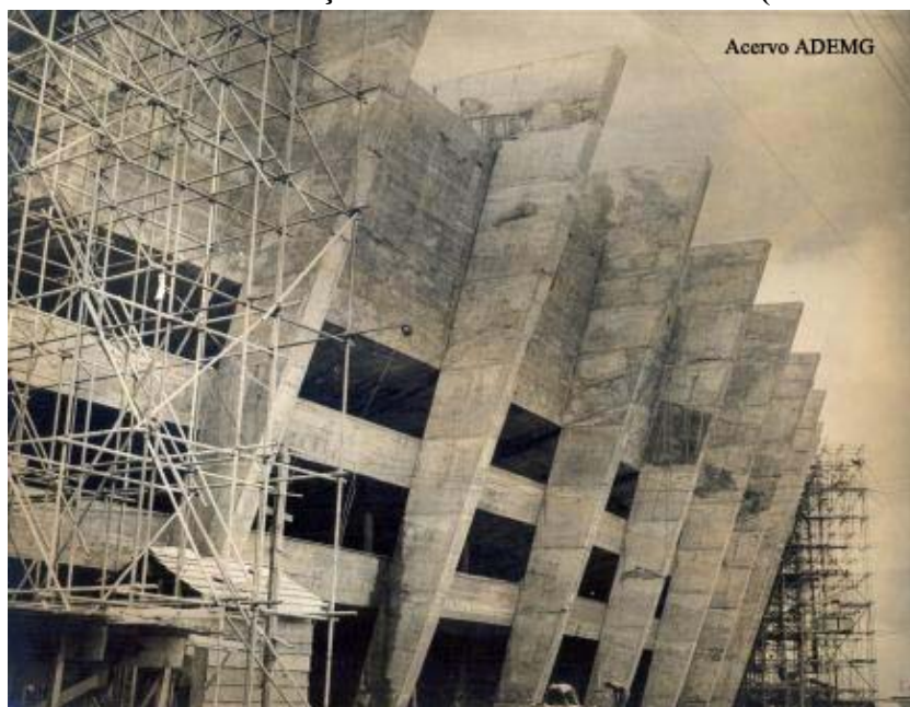
Figura 4- Obras da construção do Estádio Minas Gerais (Década de 1960)
